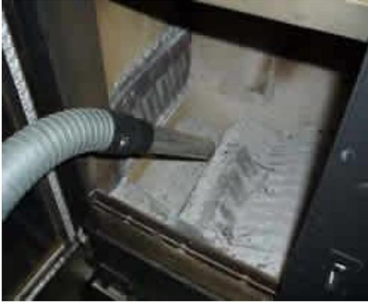
... und am besten mit einem Aschestaubsauger aussaugen.
