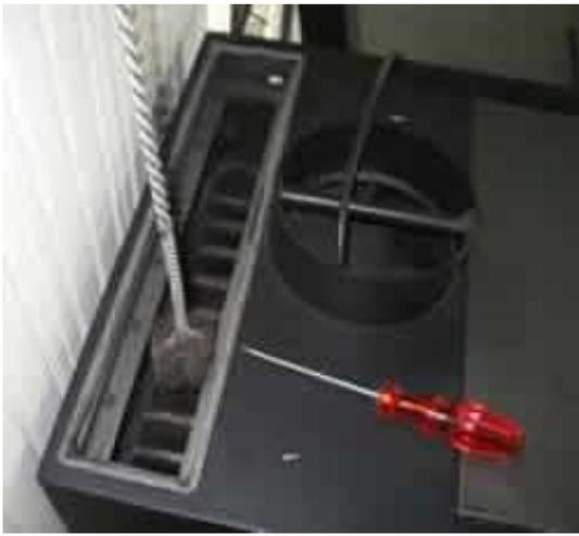
Für die Reinigung der vertikalen Rauchzüge die Abdeckung hinter dem Kaminabgang durch leichtes ankippen nach oben abziehen. Die starre Bürste immer bis ganz nach unten durchstoßen!
